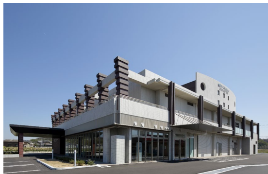
病院施設工事
