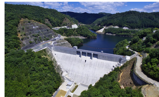
金出地ダム堤体
