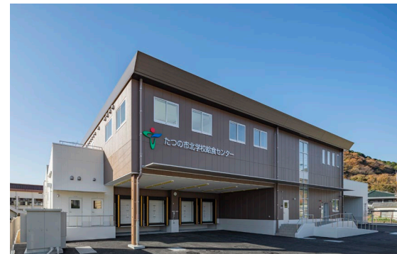
学校関連施設工事
