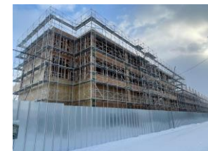
【建築中の木造4階建て賃貸住宅】
