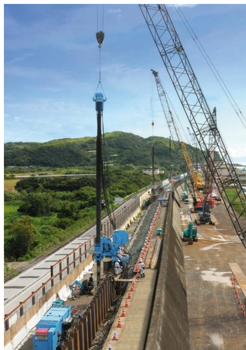
硬質地盤クリア工法
