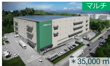
● プロロジスパーク岡山 (岡山県岡山市) 2025年8月竣工予定
