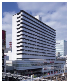
非常用発電機更新工事(北野阪急ビル)
