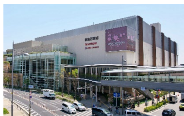
入退室管理システム・セキュリティゲート更新工事(阪急西宮ガーデンズ)
