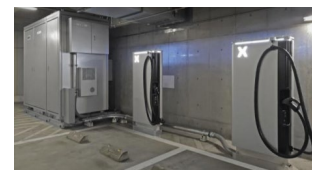
EV充電ステーションの設置
