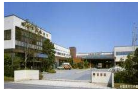
寿製菓(株) 本社工場
