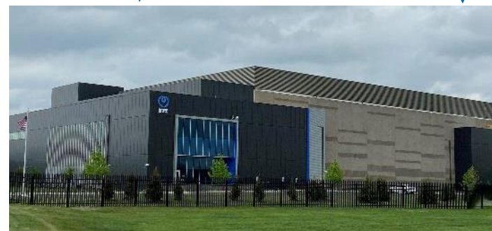
<米国・シカゴ データセンター>
