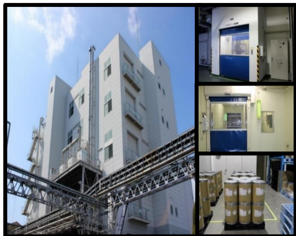
泉工場製造棟 (大阪府泉大津市)
