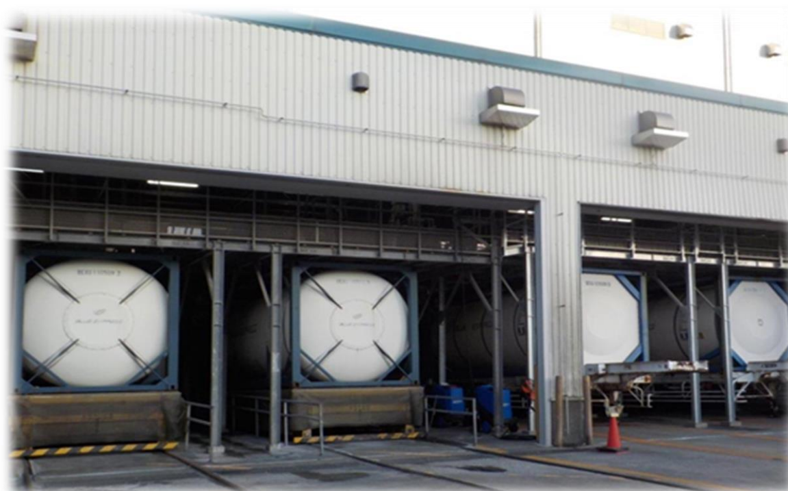
危険品タンクコンテナ洗浄レーン 横浜営業所（2024年7月運用開始）
