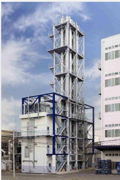
濃縮プラント (大阪府泉大津市)
