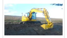
GNSSと3D-MCを活用することで設計データ通りに高精度かつ効率的に施工を行うことができました。また、掘削補助員を必要とせず丁張りなどの敷設を減らし熟練者のオペレーターでなることではり高品質から操作できるるとにより高品した。また、設計データ位置の較差が重要になるため、国際に対応し安定している当社の配が「CT施工においてとても有用です。
