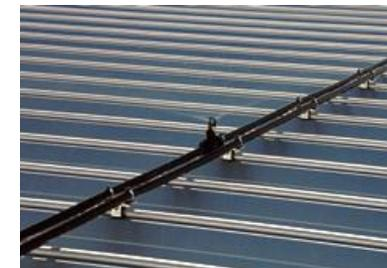
倉庫内温度低減のために井戸水を利用した屋根散水設備の設置
