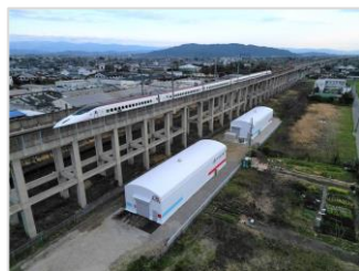
系統用蓄電事業 (でんきの駅)
