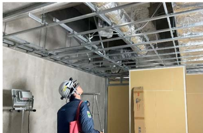
▲ スマートグラスを活用した遠隔サポート
