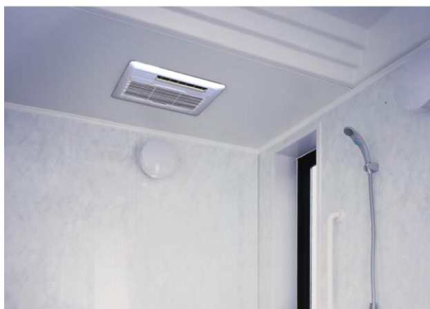
浴室の天井に設置
