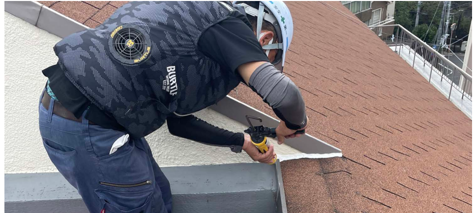
▲シーリング工事
