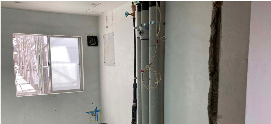
▲給排水管更新
