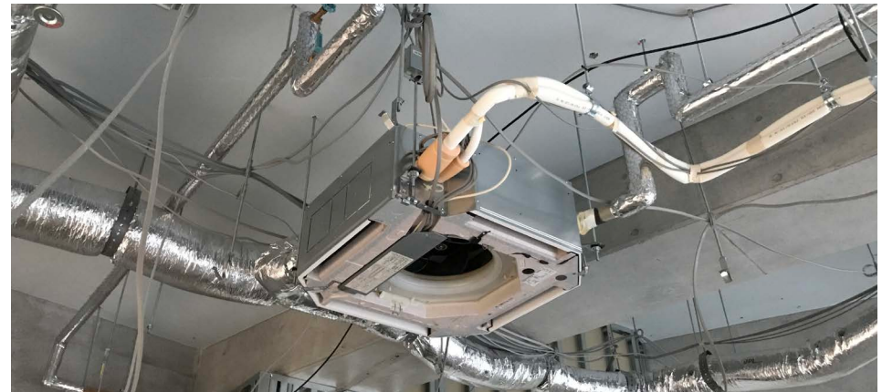
▲空調設備更新
