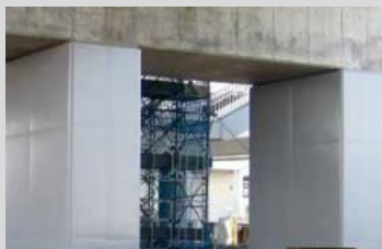
耐震補強鋼板
