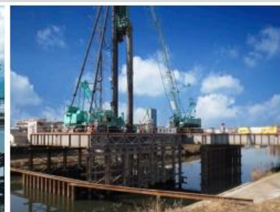
大型重機作業用仮橋(埼玉県)
