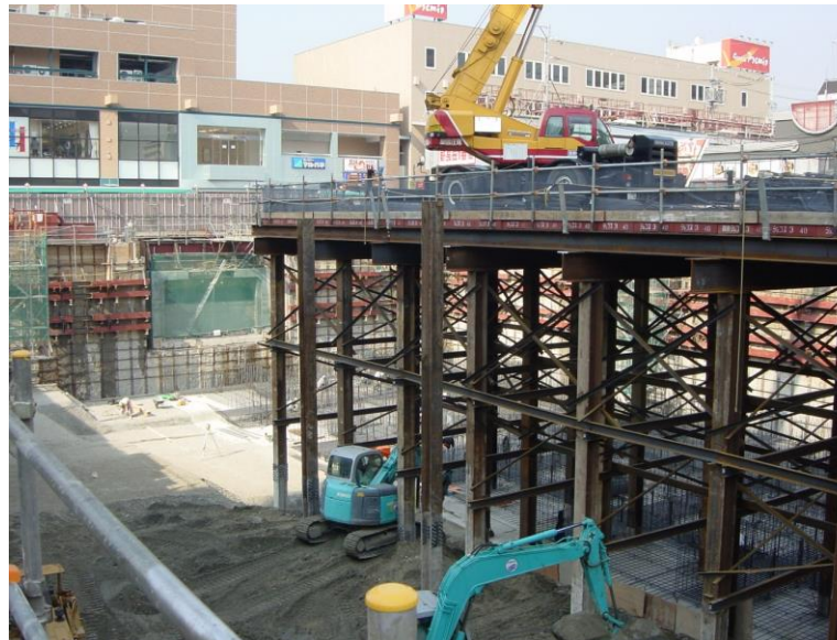
作業構台設置・掘削
