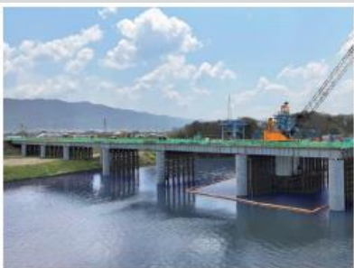
架替工事用仮橋(福岡県)
