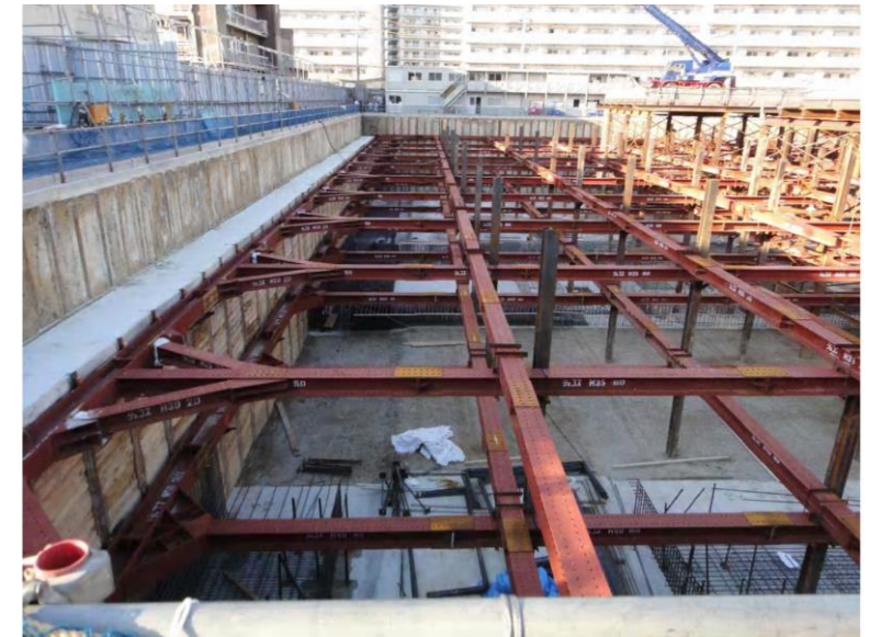
支保工設置・躯体構築
