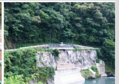
災害時応急用仮橋(徳島県)
