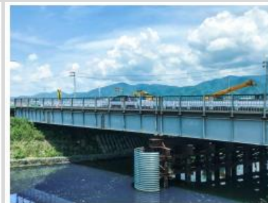
架替用迂回路仮橋(京都府)
