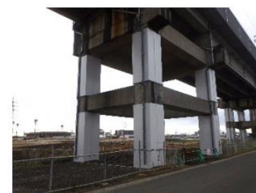
大規模地震対策（新幹線高架橋柱）
