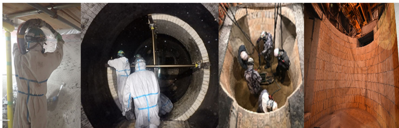
焼却炉／ロータリーキルン／溝形誘導炉工事施工例
