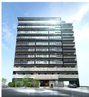
エスリードザ・グラン大阪サウス
