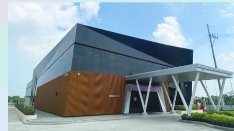
フィリピン・テクニカルセンター マニラ首都圏北方の ブラカン州パラリス工業団地内に開設した 研修センターと加工工場の複合施設 (2024.10.9開所)
