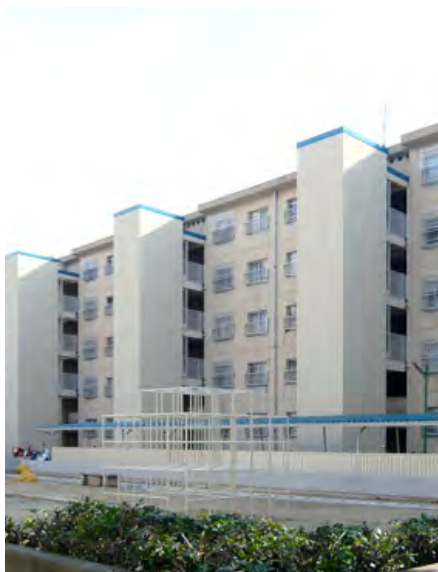
階段室型エレベーター
