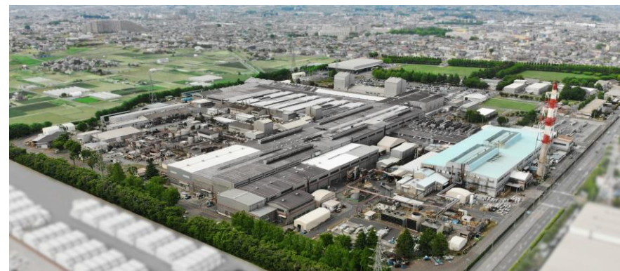
深谷製造所全景
