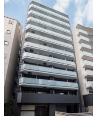
マンション施工事例
