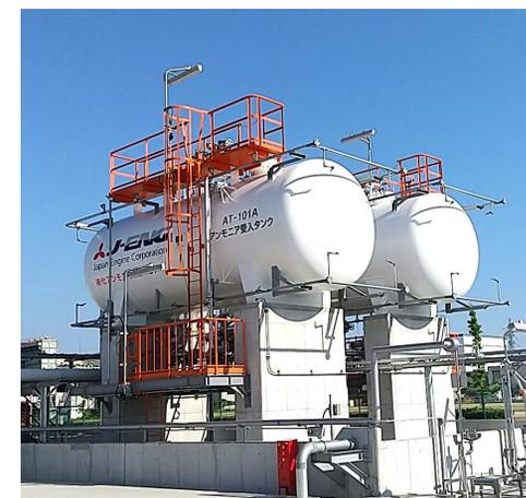
アンモニア燃料供給装置(貯槽)
