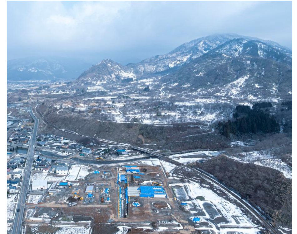
泊川中間養殖場建設地（2025年3月撮影）
