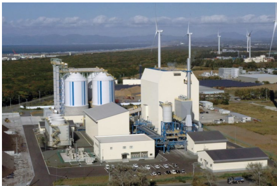
[写真：石狩新港バイオマス発電所]
