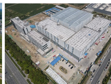
SMC中国 常州倉庫(常州市) (2025年5月完成予定)
