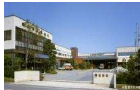
寿製菓(株) 本社工場
