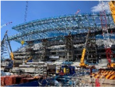
広島サッカー スタジアムの建設
