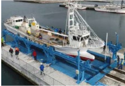
大洗漁港の 船舶上架施設
