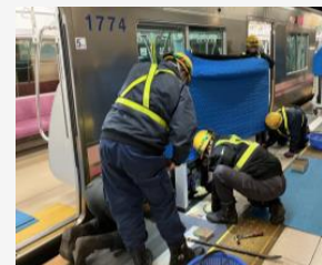
搬入から設置
