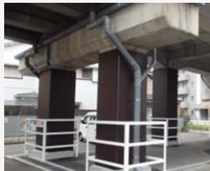
高架橋耐震補強
