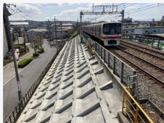
法面耐震補強
