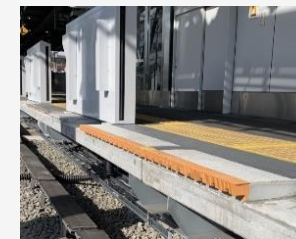
転落防止ゴムの設置 ホームかさ上げ
