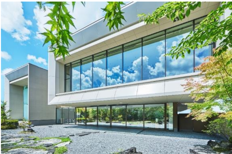
郡山モノリス （福島県郡山市）
