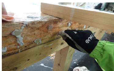
白蟻被害箇所の樹脂補修
