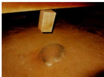
仕入後に床下沈下が発見された事例。大規模に基礎を作りなおす必要が生じた
