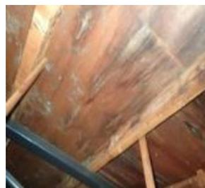
販売後に発生した雨漏りの事例。瑕疵担保責任(当時)により全面補修した
