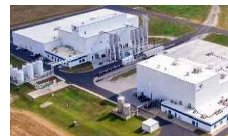
RIKEN ELASTOMERS CORPORATION 塩ビコンパウンド生産設備増設
