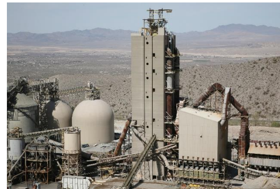
米国三菱セメント社 クッセンベリー工場 プラント
