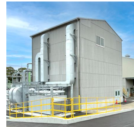
2025年5月に竣工した五興化成乾燥粉体棟
