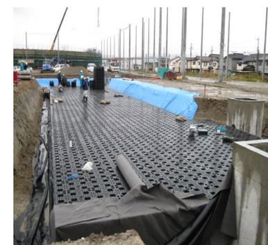
「ジオプールAE-1工法」を用いた当社の雨水貯留浸透施設です。目的別に施工タイプ(貯留型、雨水利用、浸透型、浸透貯留型)を用意しており、パーミアコンとリ・タンスイシステムを組み合わせることで、より高い雨水貯留浸透機能を発揮させることが可能です。また、容器リサイクル法に基づく家庭ごみのプラスチック材を原材料として再利用しており、環境保護にも寄与しております。
