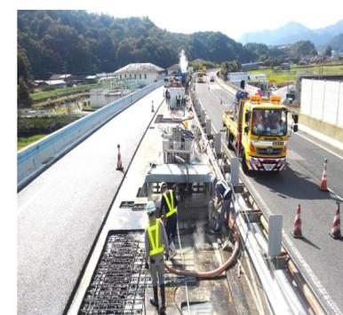
水のかきで洗う、剥がす、削る、切るといった超高圧の水噴流を利用したウォータージェット工法は環境に優しく、繊細な作業性能と超高圧力が生み出す強靱なパワーを持った新しい加工システムです。特に、コンクリート残存構造物のコンクリート除去作業では、従来工法と比べ、衝撃によるマイクロクラック、騒音および粉塵の発生を抑制します。
