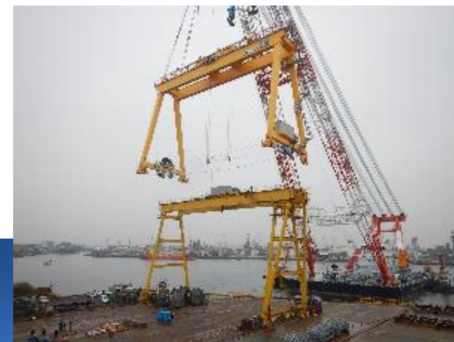
FC(フローティングクレーン)による 門型クレーン搬入
