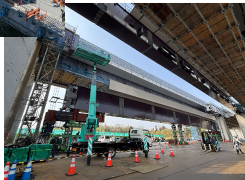
杣川橋工事 西日本高速道路株式会社
