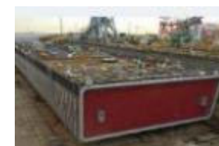
東京港海の森トンネル沈埋函
