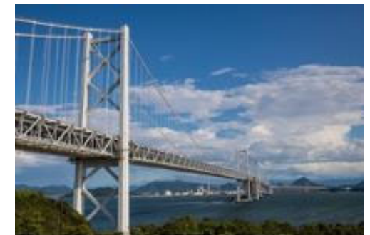
北備讃瀬戸大橋・南備讃瀬戸大橋
