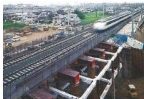
東海道新幹線箕輪架道橋
