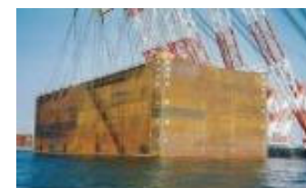
南本牧鋼製ケーソン
