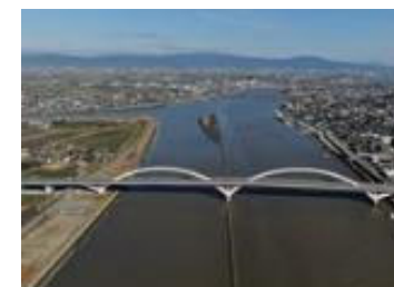
有明筑後川大橋
