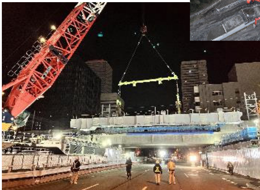
北海道新幹線札幌駅創成工区 清水・岩田地崎・伊藤・札建JV
