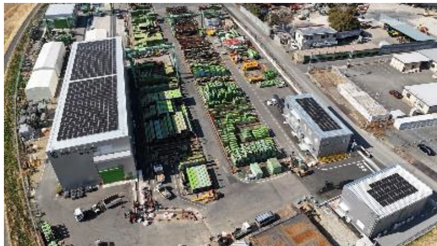
宮地エンジニアリング(株) 栗橋機材センター 各建屋屋上に太陽光発電パネルの設置完了
