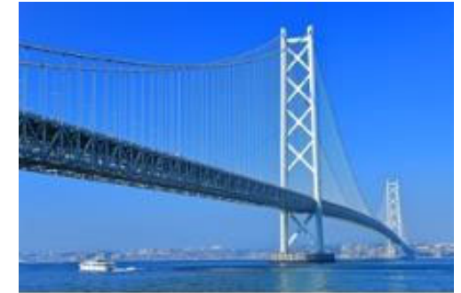
明石海峡大橋
