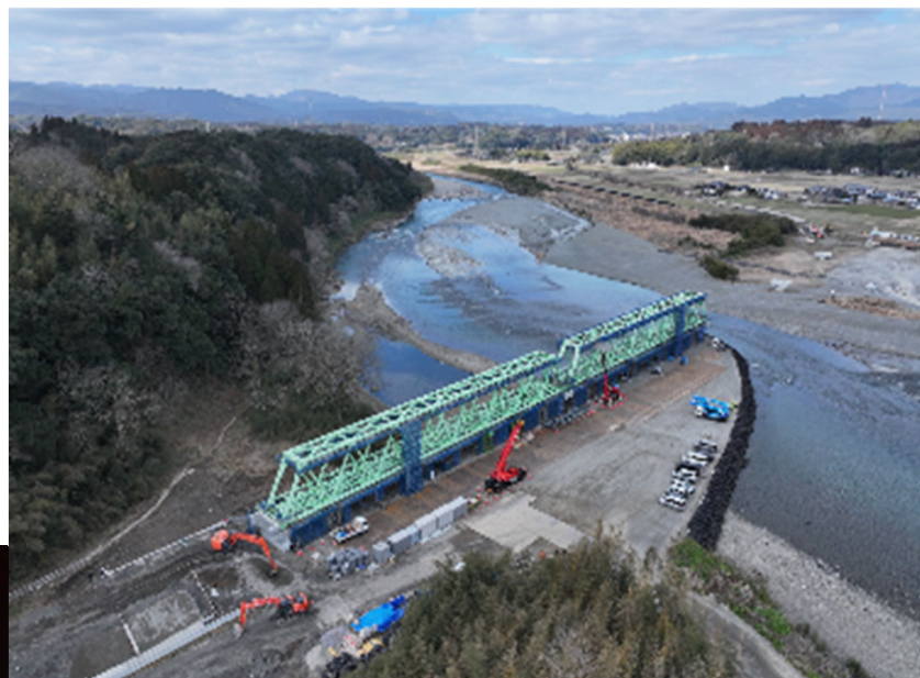
球磨川第四橋梁建設(第二期)工事 九鉄工業株式会社
