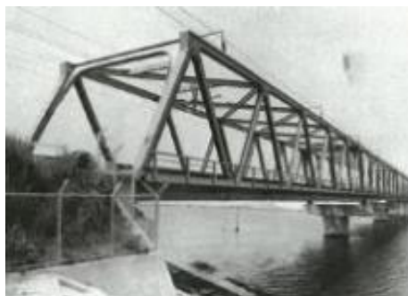
東海道新幹線江川橋梁
