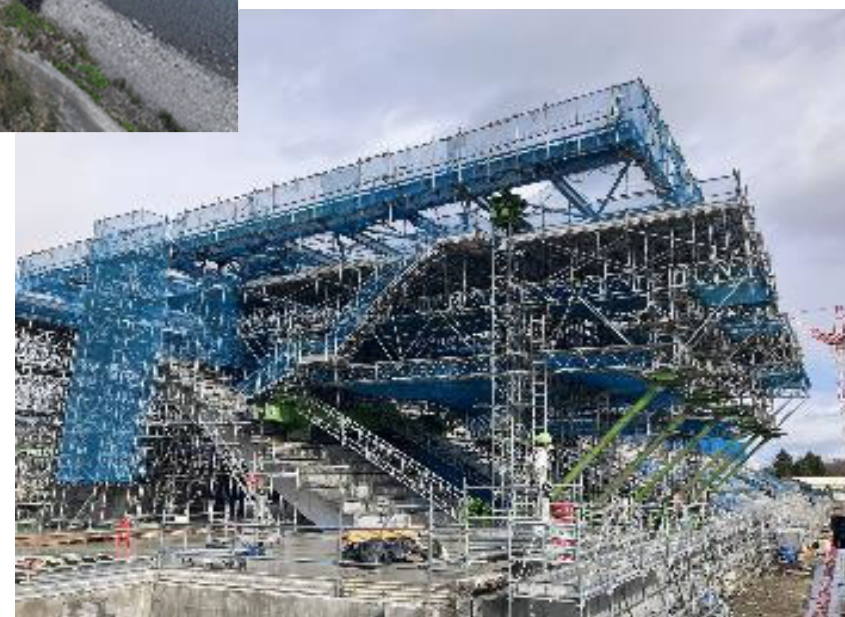
松本平広域公園陸上競技場 整備事業 清水・松本土建JV
