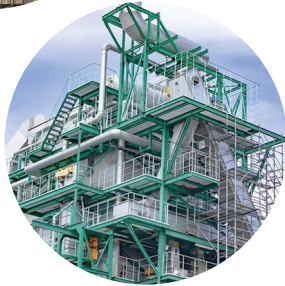
バイオマス発電施設
