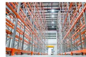
大規模倉庫用ラック
