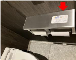
【トイレ内 Reffプレート設置】
